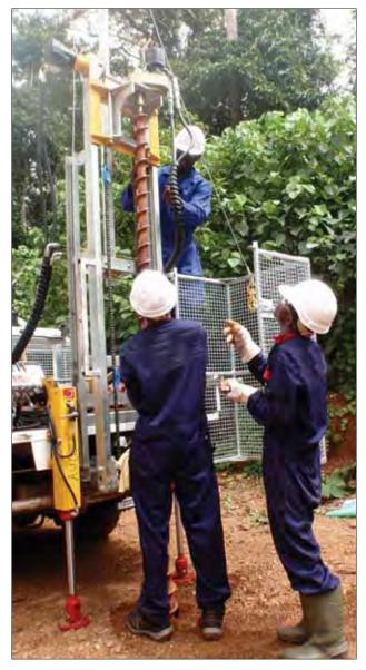
FIGURE 7: AUGER DRILLING ALONG THE RAIL ROUTE
